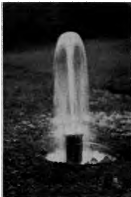
Abb. 26. Unverschlossenes Bohrloch mit artesischem Wasseraustritt im Grumbachtal.
